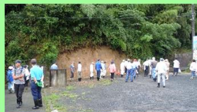
【山肌が崩れています】
