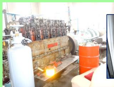
【神島ポンプ場もポンプ室が≒40cm浸水しエンジンが一時ダウンしました】
